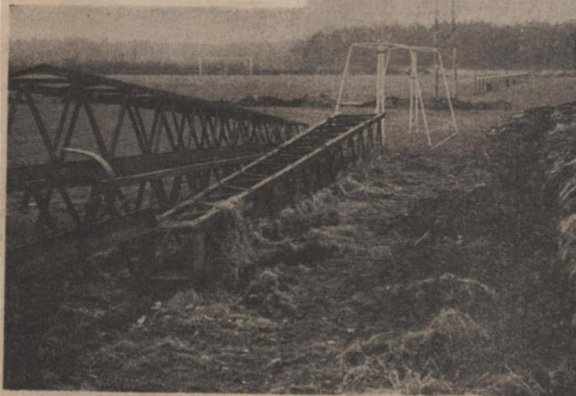
Spätestens im Sommer werden sämtliche Masten auf dem Sportplatz des VfR Wilsche errichtet sein. Die Leitungen sind schon verlegt.
